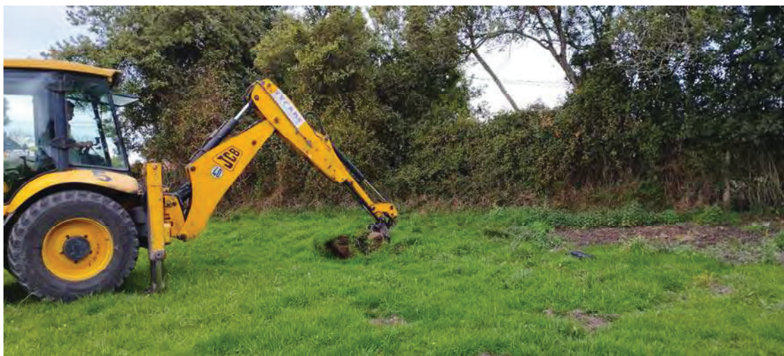
Foto.20. Emplazamiento y proceso de ejecución de la calicata C-7.
