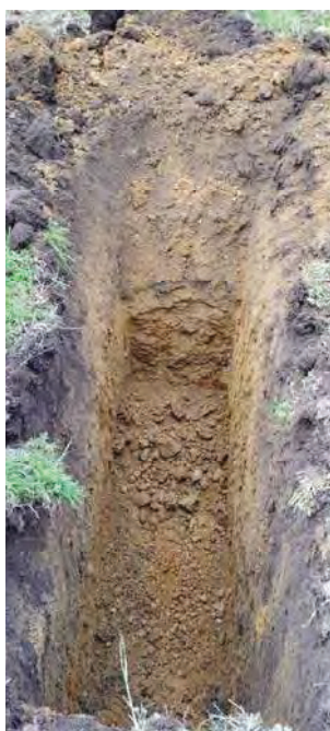
Foto.55. Interior de la calicata C-18.
