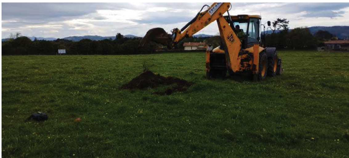
Foto.59. Emplazamiento y proceso de ejecución de la calicata C-20.
