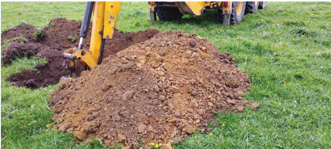
Foto.18. Acopio de material de excavación de la calicata C-6.
