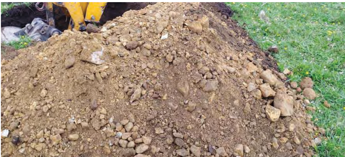
Foto.24. Acopio de material de excavación de la calicata C-8.
