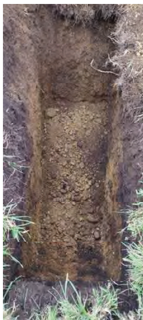
Foto. 7. Interior de la excavación de la calicata C-2.
