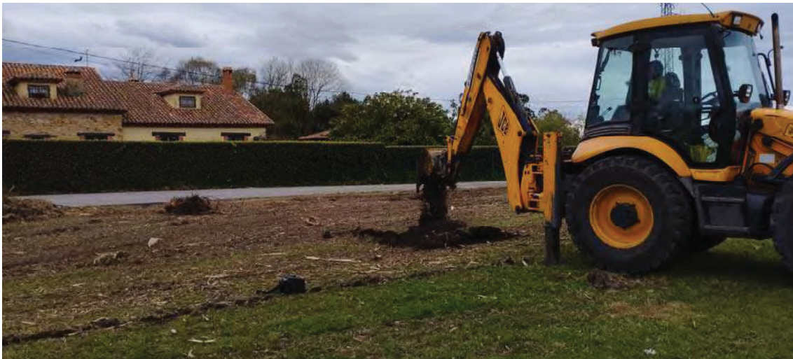
Foto.56. Emplazamiento y proceso de ejecución de la calicata C-19.
