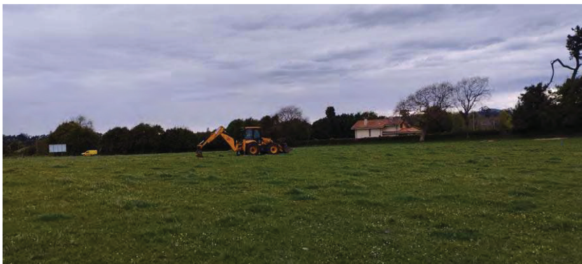
Foto.47. Emplazamiento y proceso de ejecución de la calicata C-16.
