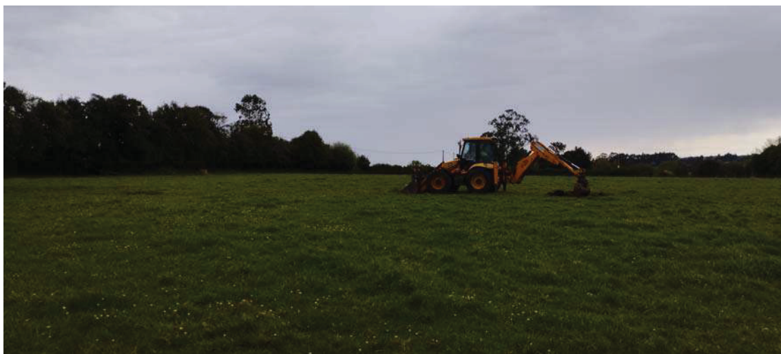
Foto.35. Emplazamiento y proceso de ejecución de la calicata C-12
