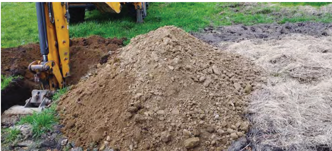
Foto.42. Acopio de material de excavación de la calicata C-14.
