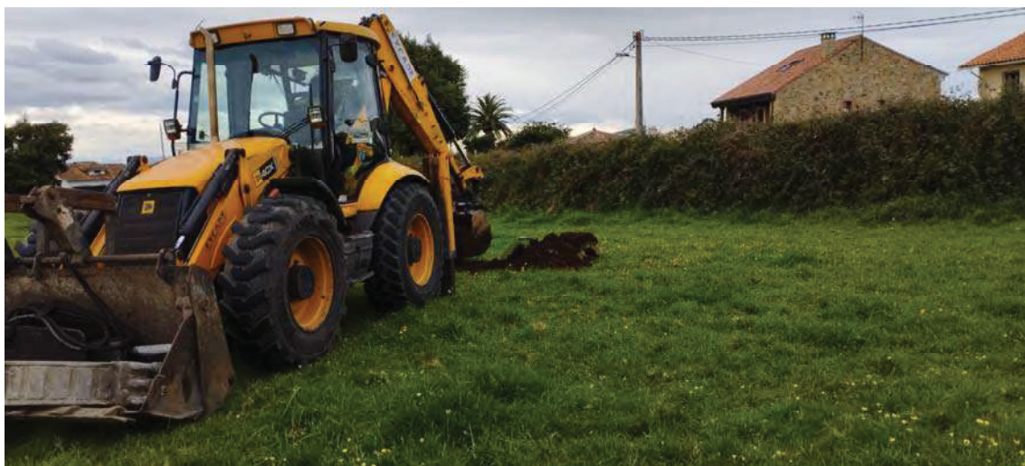
Foto.29. Emplazamiento y proceso de ejecución de la calicata C-10.
