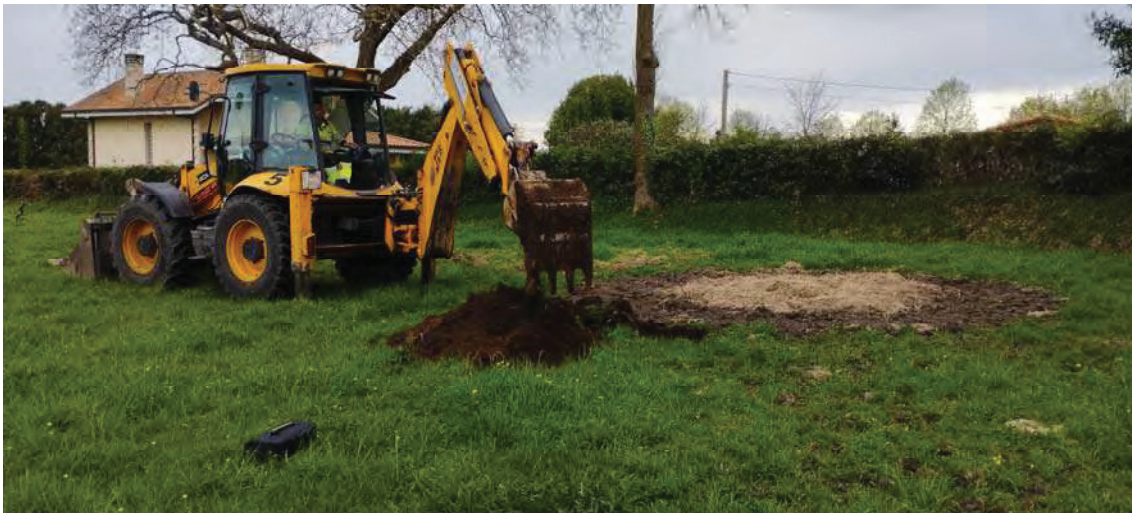
Foto.41. Emplazamiento y proceso de ejecución de la calicata C-14.
