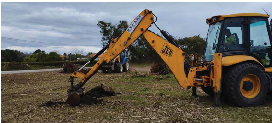
Foto.62. Emplazamiento y proceso de ejecución de la calicata C-21.
