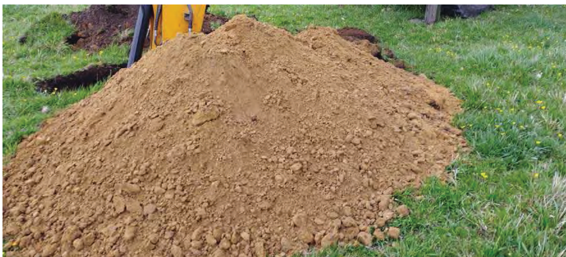
Foto.48. Acopio de material de excavación de la calicata C-16.
