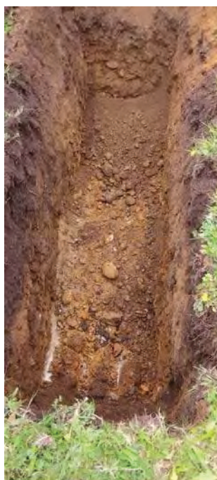
Foto.22. Interior de la calicata C-7.
