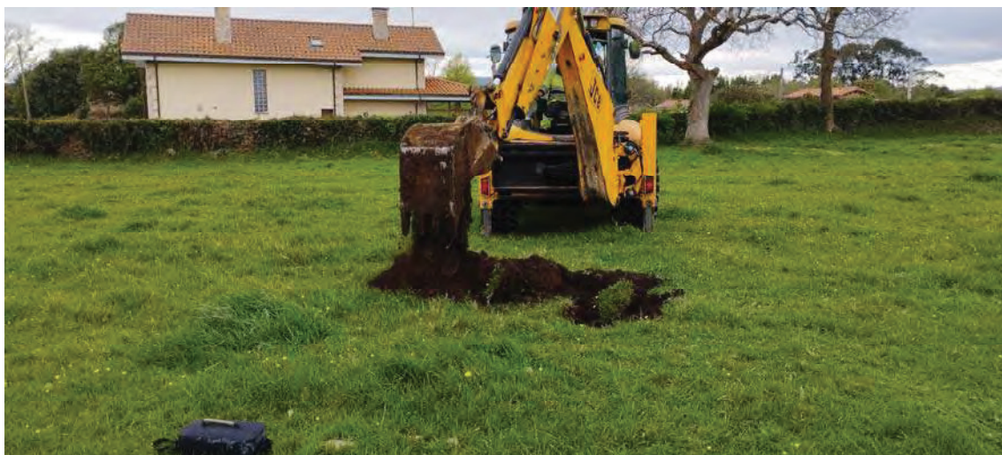
Foto.38. Emplazamiento y proceso de ejecución de la calicata C-13.
