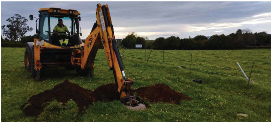
Foto.11. Emplazamiento y proceso de ejecución de la calicata C-4.
