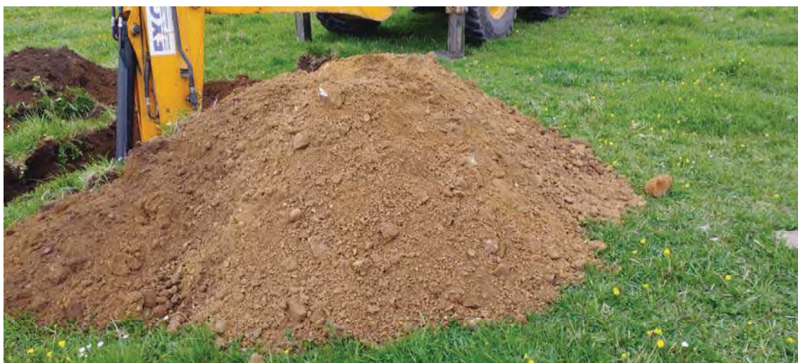
Foto.45. Acopio de material de excavación de la calicata C-15.
