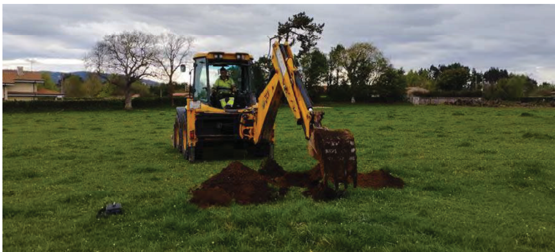
Foto.32. Emplazamiento y proceso de ejecución de la calicata C-11
