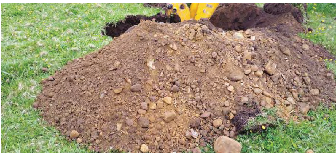
Foto.21. Acopio de material de excavación de la calicata C-7.
