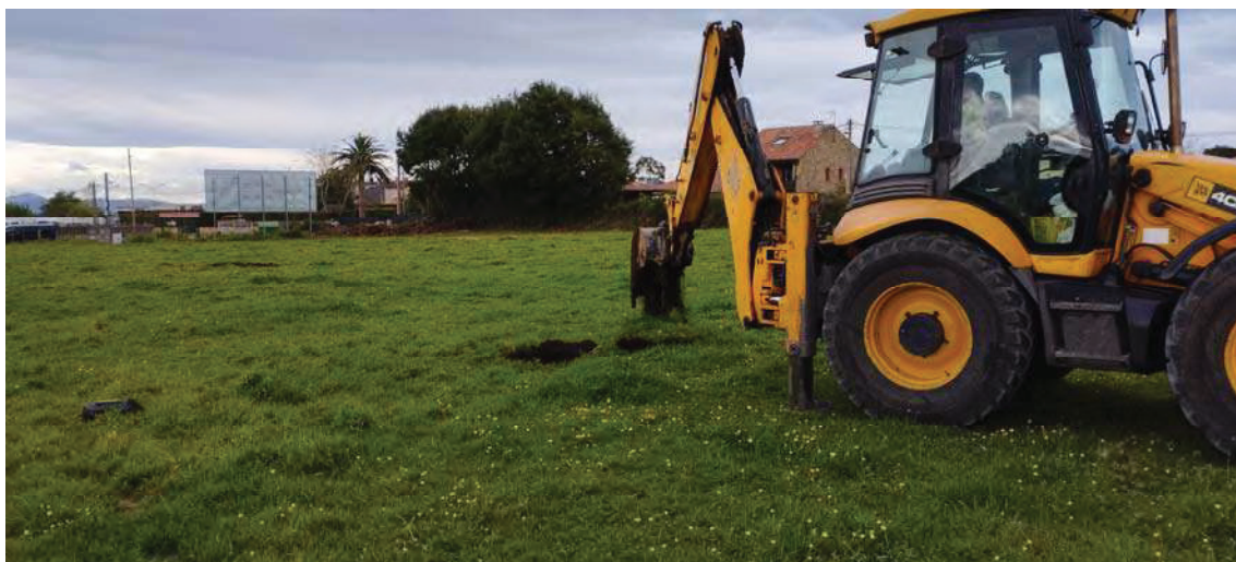
Foto. 8. Emplazamiento y proceso de ejecución de la calicata C-3.
