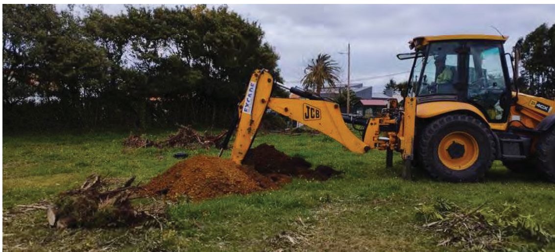
Foto.65. Emplazamiento y proceso de ejecución de la calicata C-22.
