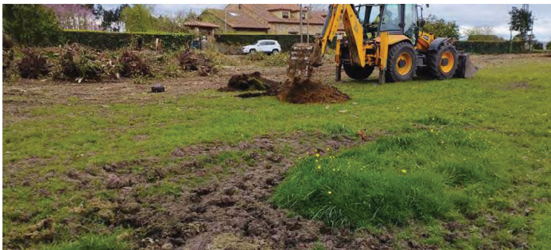
Foto.53. Emplazamiento y proceso de ejecución de la calicata C-18.
