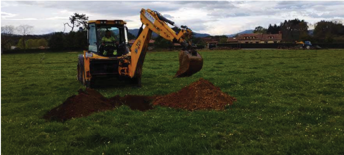
Foto.17. Emplazamiento y proceso de ejecución de la calicata C-6.
