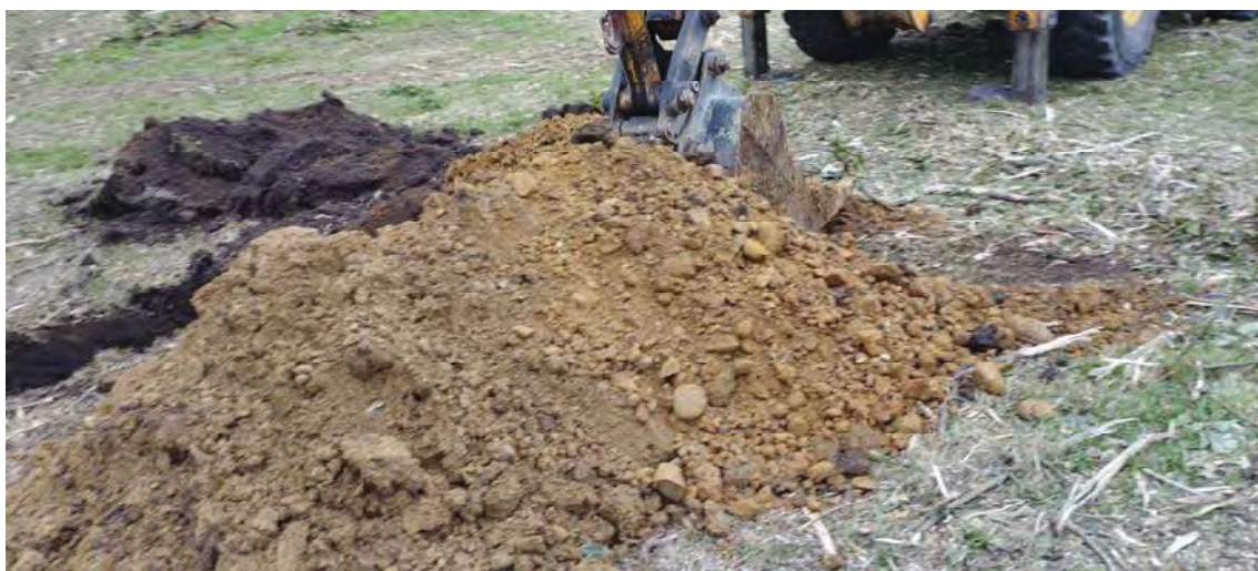
Foto.63. Acopio de material de excavación de la calicata C-21.
