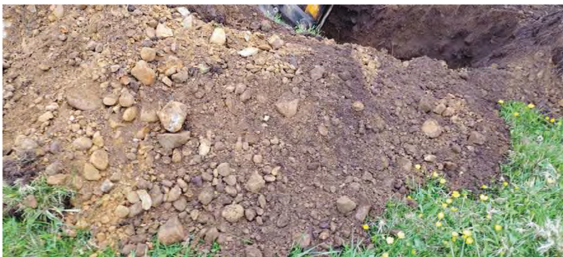
Foto.36. Acopio de material de excavación de la calicata C-12.
