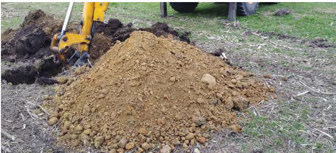
Foto.57. Acopio de material de excavación de la calicata C-19.
