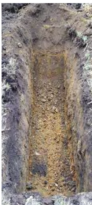
Foto.64. Interior de la calicata C-21.
