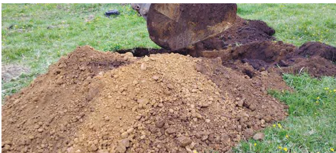
Foto.66. Acopio de material de excavación de la calicata C-22.
