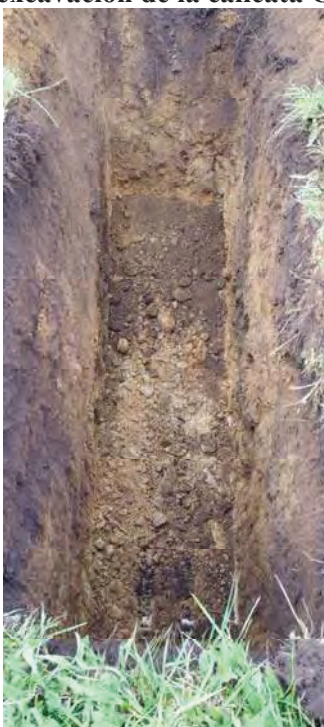
Foto.67. Interior de la calicata C-22.
