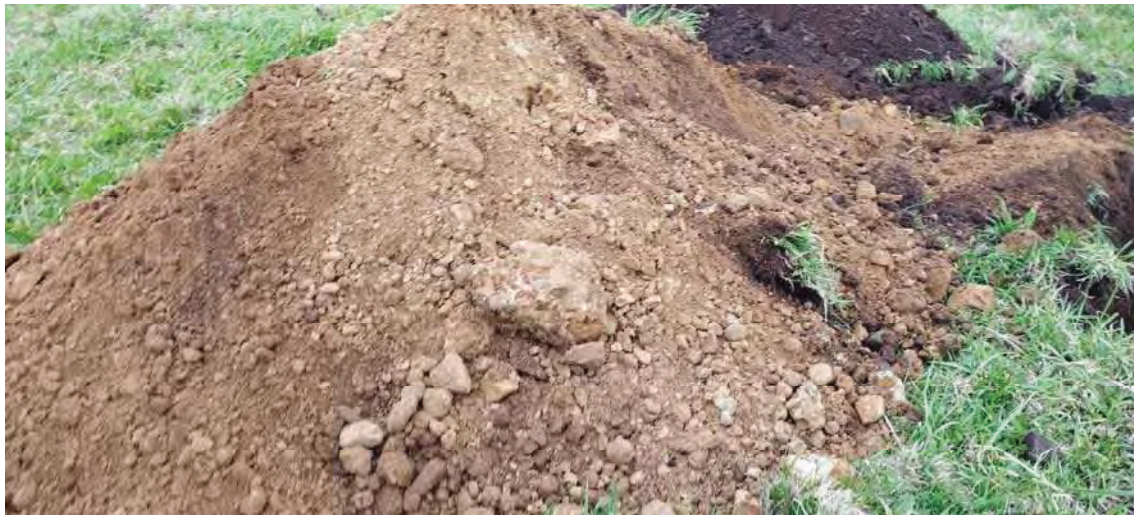
Foto. 3. Acopio de material de excavación de la calicata C-1.
