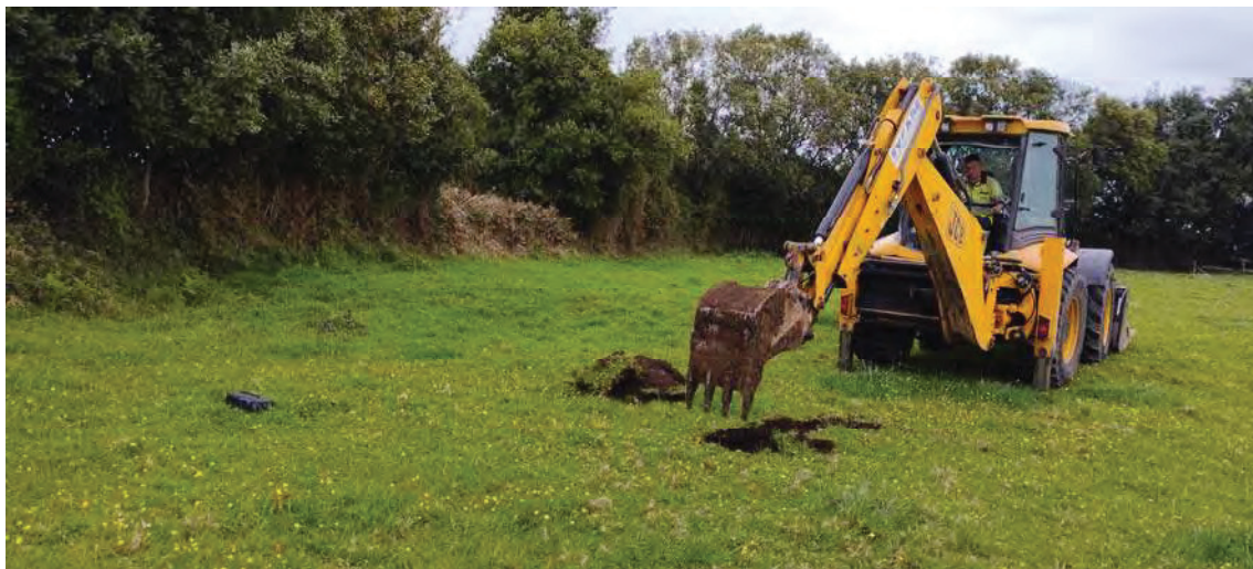
Foto.26. Emplazamiento y proceso de ejecución de la calicata C-9.
