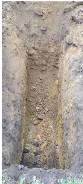
Foto.19. Interior de la calicata C-6.
