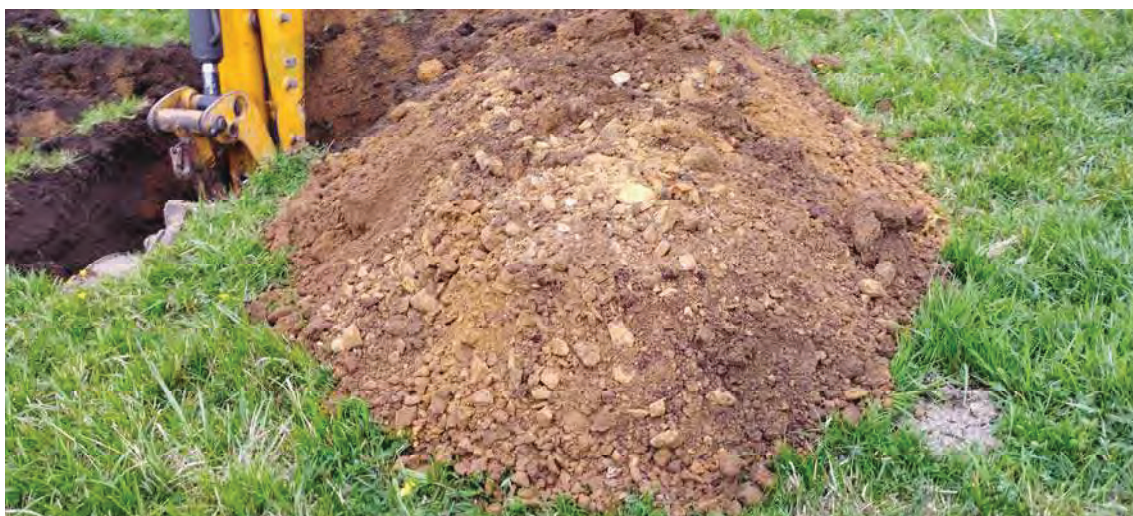
Foto.33. Acopio de material de excavación de la calicata C-11.
