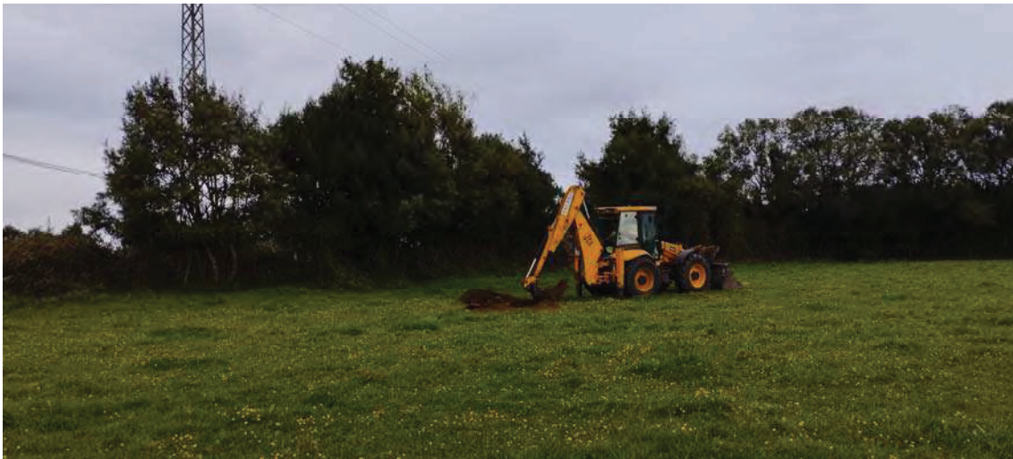
Foto.23. Emplazamiento y proceso de ejecución de la calicata C-8.
