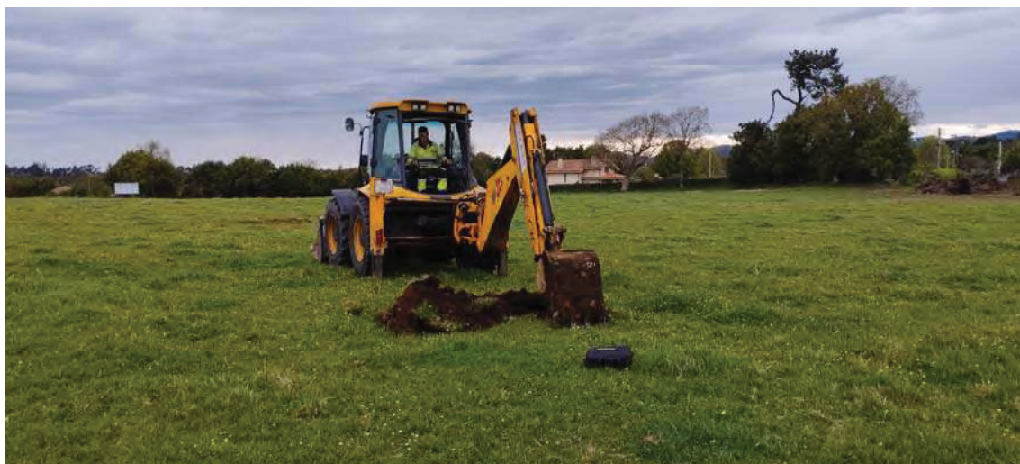
Foto.50. Emplazamiento y proceso de ejecución de la calicata C-17.
