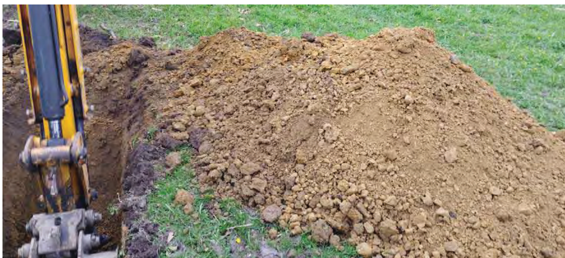
Foto.54. Acopio de material de excavación de la calicata C-18.
