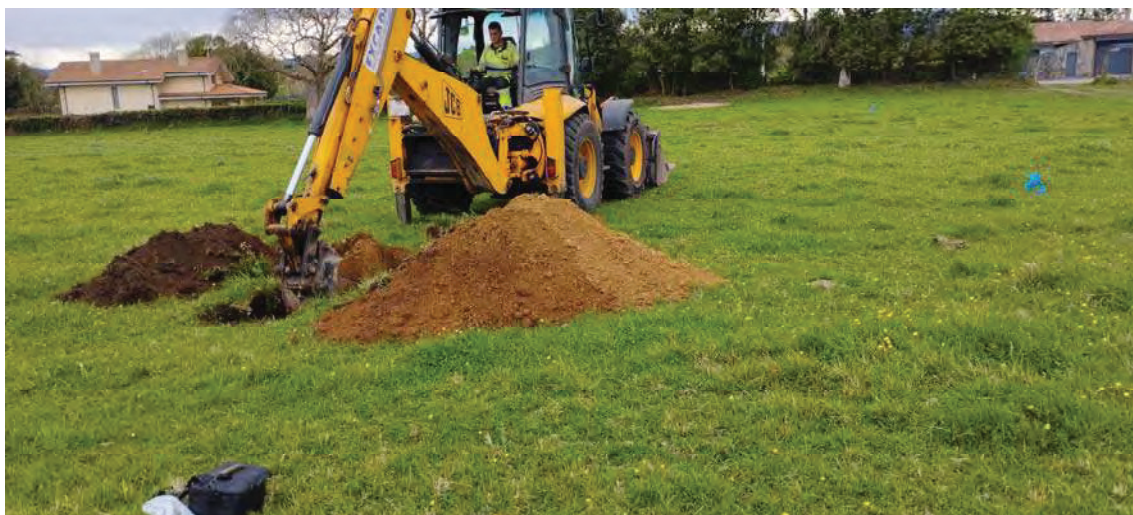
Foto.44. Emplazamiento y proceso de ejecución de la calicata C-15.
