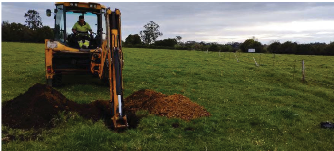
Foto. 5. Emplazamiento y proceso de ejecución de la calicata C-2.
