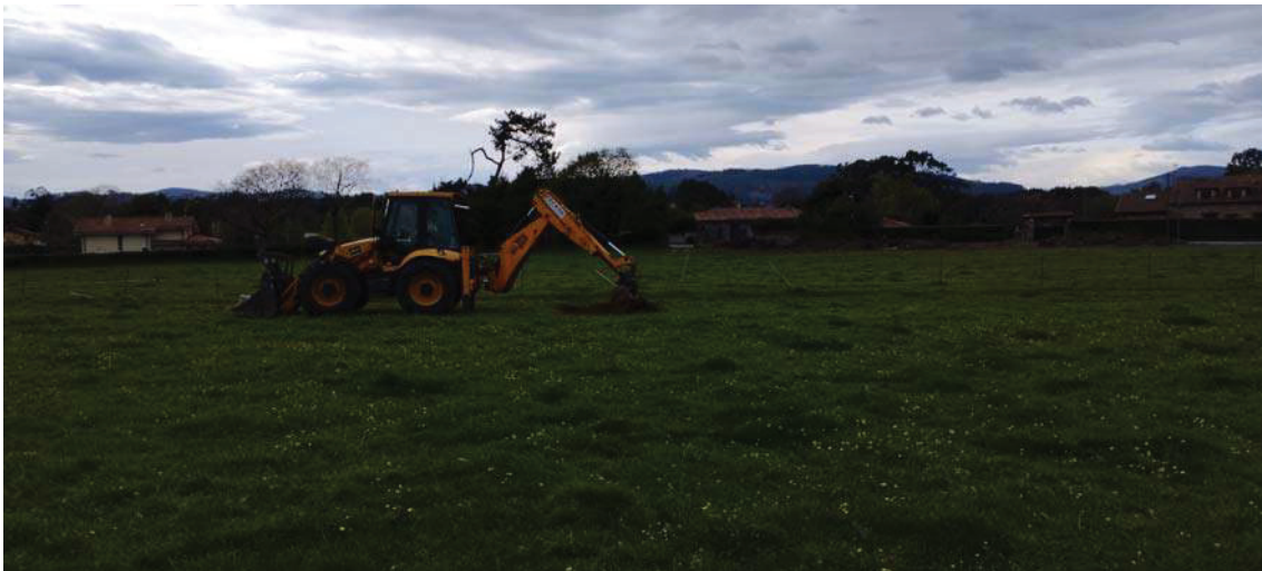
Foto.14. Emplazamiento y proceso de ejecución de la calicata C-5.
